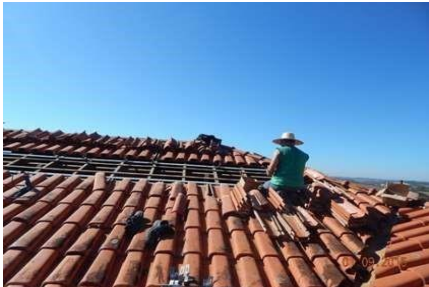
FIGURA 33 – Foto da Montagem da Usina Solar dos Lotte
