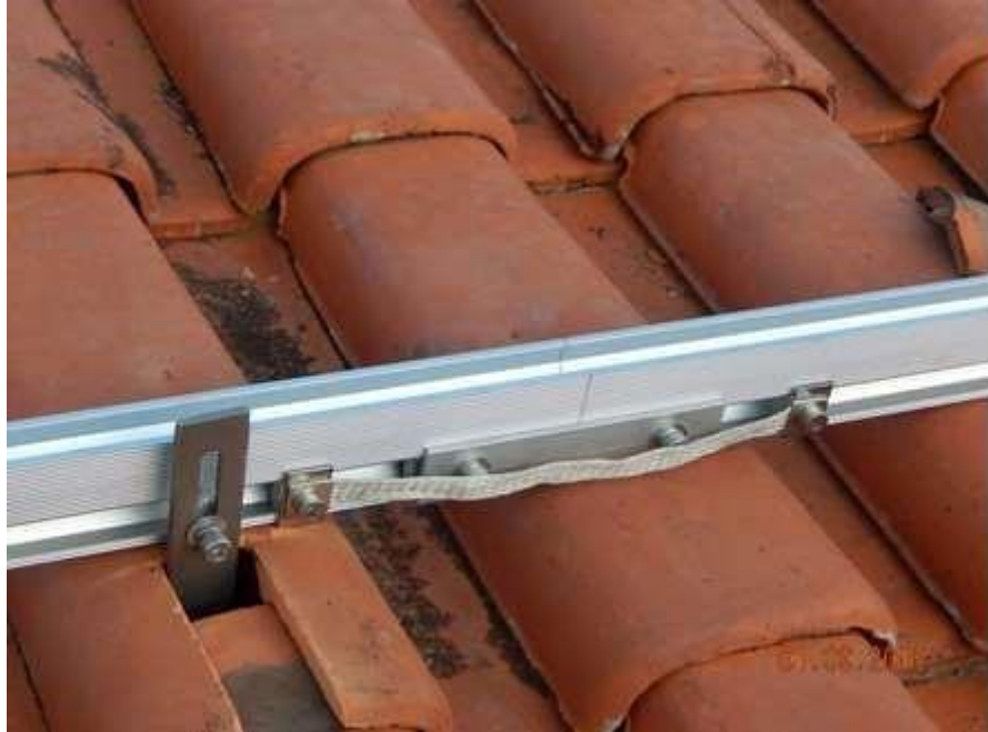
FIGURA 36 – Foto da Montagem da Usina Solar dos Lotte
