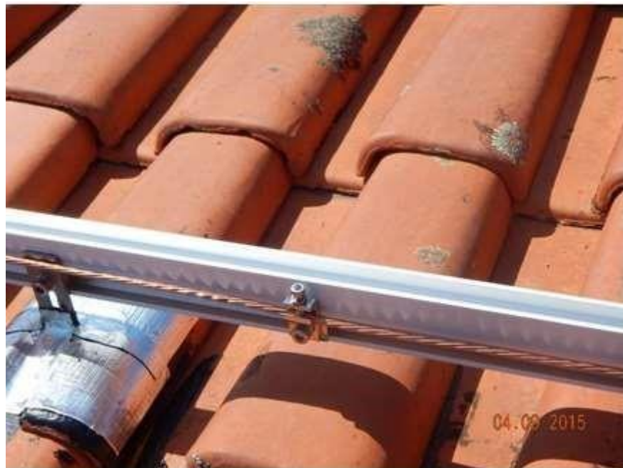
FIGURA 37 – Foto da Montagem da Usina Solar dos Lotte
